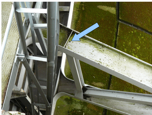
rameno segmentu s patrným odvodňovacím otvorem
