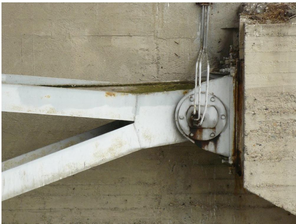
Foto č. 7 – Mazání ložiska ramene segmentového uzávěru
