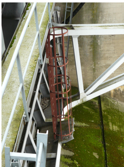
středový ocelový žebřík bude nahrazen novým nerezovým
