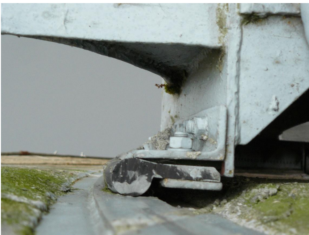
Foto č. 6 – Boční těsnění segmentového uzávěru s těsnící šavlí
