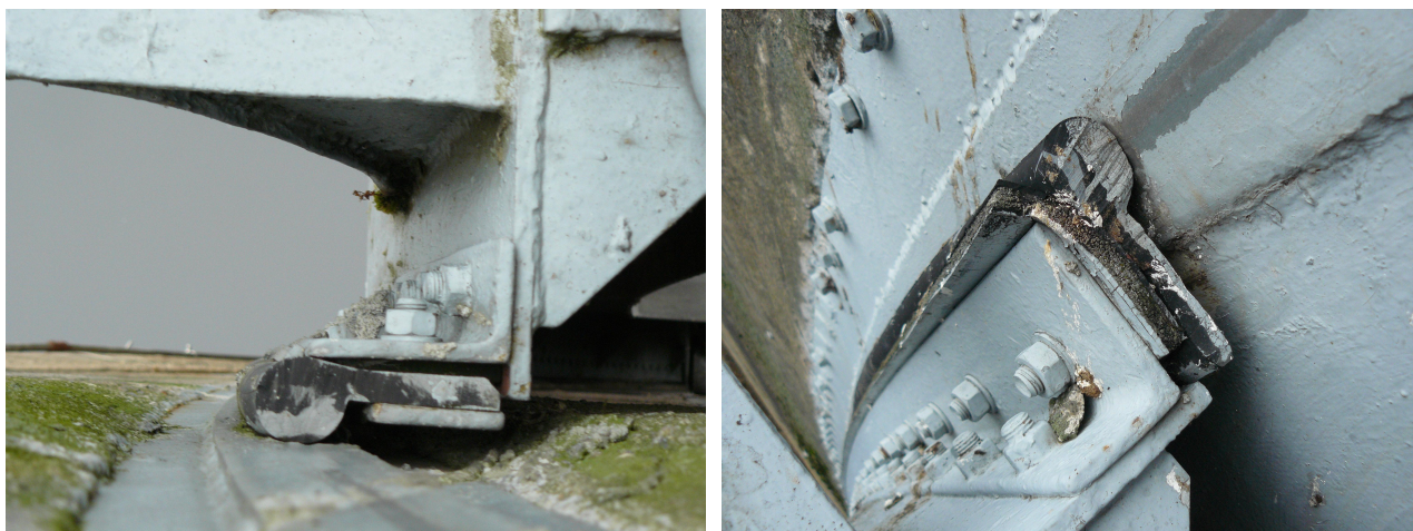
Příklady detailů bočního těsnění segmentů s různým vypodložením hlavního těsnícího pásu
