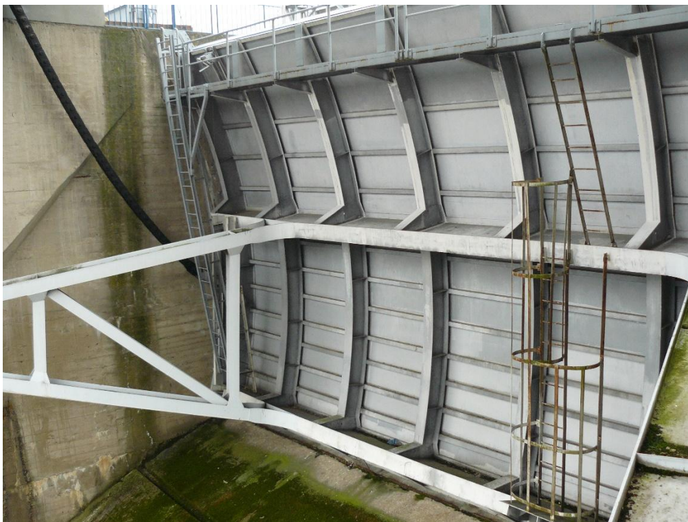
Foto č. 1 – Pohled na segmentový uzávěr proti vodě s detailem žebříku
